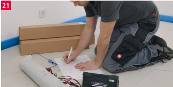
Widerstand nach dem Anschluss der Kabel erneut überprüfen und Werte im Prüfprotokoll sowie in der Montage-Skizze dokumentieren.
