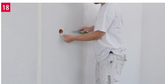
Einbauten können bis zu einem  $\varnothing$  70 mm nachträglich eingebracht werden.
