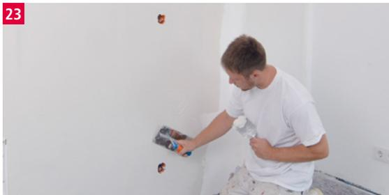
Belag- und Deckschicht gemäß Herstellerangaben aufbringen.
