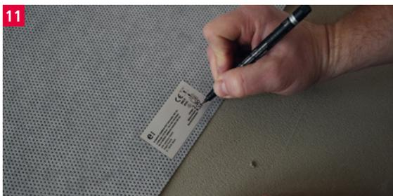
Widerstände zugeschnittener Folien erneut messen und auf Etikett, im Prüfprotokoll und der Montage-Skizze dokumentieren – Sollwerte den Widerstandstabellen entnehmen.
