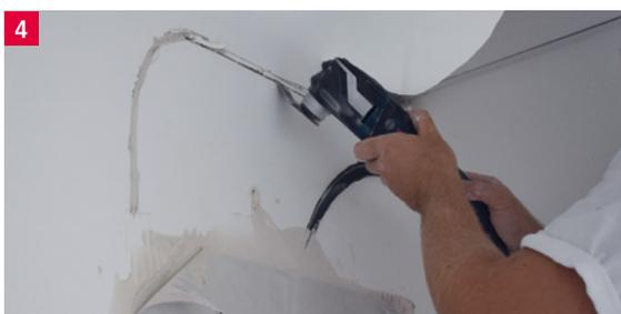
Aussparungen für die Zuleitungen und Kontaktierungen der Heizfolien einbringen.
