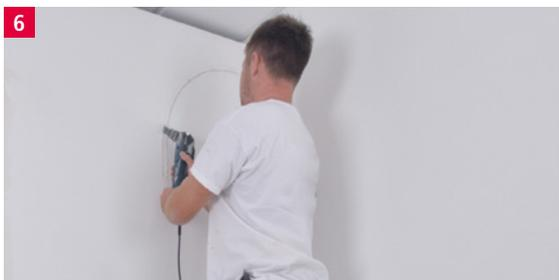
Aussparung für Fühler-Anschluss-Set vorsehen. Fühlerhülse mittig unter der Heizfolie anordnen.
