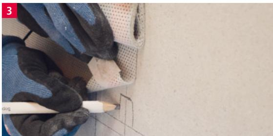
Kabelführungen sowie Aussparungen für die Heizfolienkontakte anzeichnen.
