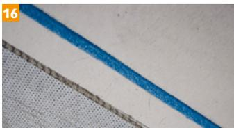
**16** Heizfolie nicht über Dehnungsfugen verlegen und in einem Abstand von mind. 2 cm vor der Dehnungsfuge enden lassen.
