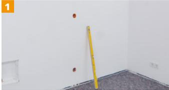
**1** Ebenen, sauberen, tragfähigen Untergrund vorbereiten. Trockenbauplatten und Holzwerkstoffplatten sind im Stoßbereich rissüberbrückend auszuführen.
