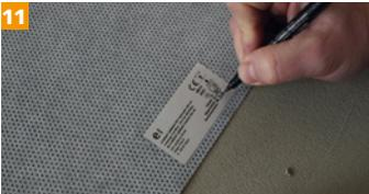
Widerstände zugeschnittener Folien erneut messen und auf Etikett, im Prüfprotokoll und der Montage-Skizze dokumentieren – Sollwerte den Widerstandstabellen entnehmen.
