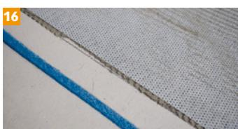
Heizfolie nicht über Dehnungsfugen verlegen und in einem Abstand von mind. 20 mm vor aufsteigenden Bauteilen (z. B. Wänden) enden lassen.
