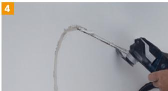
**4** Aussparungen für die Zuleitungen und Kontaktierungen der Heizfolien einbringen.
