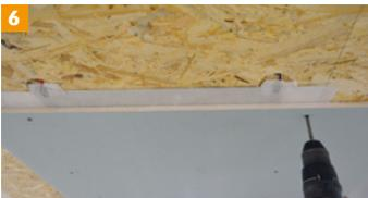
Trockenbauplatten (max. Stärke 12,5 mm) außerhalb des elektrisch aktiven Heizbereichs (410 mm) gemäß Herstellerangaben befestigen.
