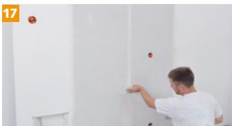
**17** Heizfolie mit Kunststoffspachtel gemäß Herstellerangaben mit Klebemörtel überziehen.
