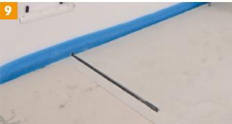
Für ideale Messwerte Metall-Endkappe bündig mit der Oberseite abschließen lassen.
