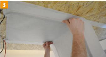
Heizfolie am Montagestreifen z. B. mit doppelseitigen Klebeband oder Tackernadeln an Unterdeckplatte befestigen.
