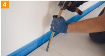
**4** Aussparungen für die Zuleitungen und Kontaktierungen der Heizfolien einbringen.
