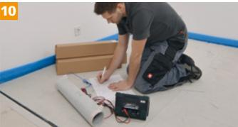
Widerstand gemäß den Widerstandstabellen überprüfen und Werte im Prüfprotokoll sowie in der Montage-Skizze dokumentieren.
