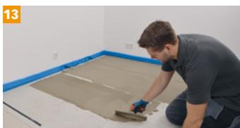
Klebermörtel zum Verkleben der Heizfolien gemäß Herstellerangaben auftragen.
