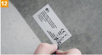
Widerstände zugeschnittener Folien erneut messen und auf dem Etikett, im Prüfprotokoll und in der Montage-Skizze dokumentieren – Sollwerte den Widerstandstabellen entnehmen.
