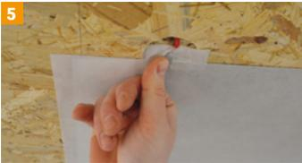
Kabel und Anschlusskontakt bündig einlassen.
