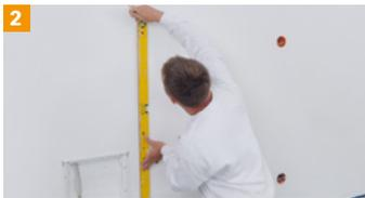
**2** Position der Heizfolien anzeichnen und den Standort des Netzteils bestimmen. Montage-Skizze erstellen.
