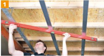
Ebene, saubere, tragfähige Unterkonstruktion vorbereiten.
