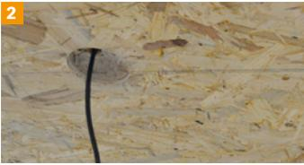
Aussparung für den Folienkontakt erstellen und Zuleitungen verlegen.
