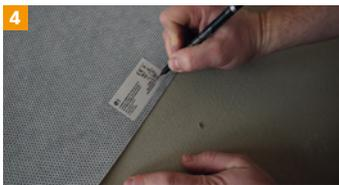
Bei zugeschnittenen Folien gemessene Widerstände auf beiliegenden Etiketten eintragen und auf der Heizfolie aufkleben.
