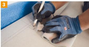
Kabelführungen sowie Aussparungen für die Heizfolienkontakte anzeichnen.
