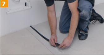
Fühler-Anschluss-Set in der Aussparung verlegen. Den externen Temperaturfühler bis zur Endkappe (Messpunkt) führen.
