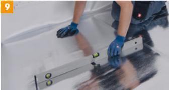
Trittschalldämmbahn aussparen und für ideale Messwerte Bodenfühlerhülse bündig mit der Oberseite der Trittschalldämmbahn (z. B. **CompactFloor DIRECT**) abschließen lassen.
