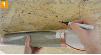
Bereich der Heizfolienkontakte an der Unterdeckplatte markieren.
