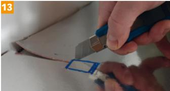
Aussparungen für die Zuleitungen und Kontaktierungen der Heizfolien einbringen.
