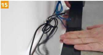
Zusätzlich an Kopf- und Fußenden die Schnittkanten von oben mit Isolierklebeband abkleben.
