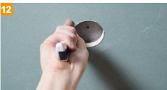
Einbauten können bis zu einem  $\varnothing$  70 mm nachträglich eingebracht werden.
