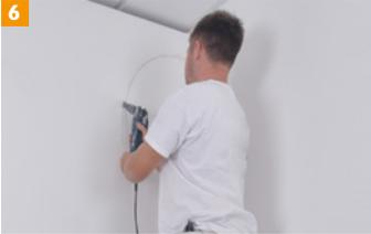
Aussparung für Fühler-Anschluss-Set vorsehen. Fühlerhülse mittig unter der Heizfolie anordnen.
