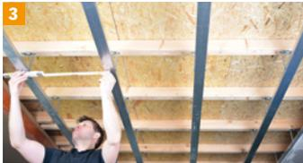
Position der Heizfolien anzeichnen und den Standort des Netzteils bestimmen. Montage-Skizze erstellen.
