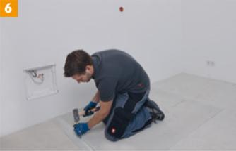
Aussparung für Fühler-Anschluss-Set vorsehen. Fühlerhülse mittig unter der Heizfolie und mind. 60 cm von der Wand in den Raum anordnen.
