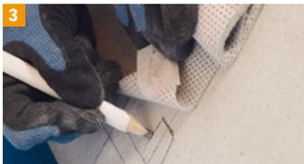
**3** Kabelführungen sowie Aussparungen für die Heizfolienkontakte anzeichnen.
