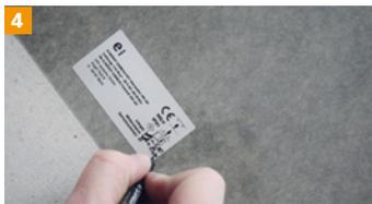
4 Bei zugeschnittenen Folien gemessene Widerstände auf beiliegenden Etiketten eintragen und auf der Heizfolie aufkleben.
