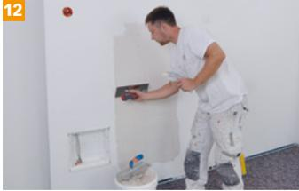
**12** Klebemörtel zum Verkleben der Heizfolien gemäß Herstellerangaben auftragen.
