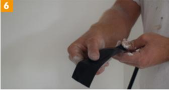
Die metallische Endkappe des Fühler-Anschluss-Sets mit Isolierklebeband abkleben um Fehlerströme zu vermeiden.
