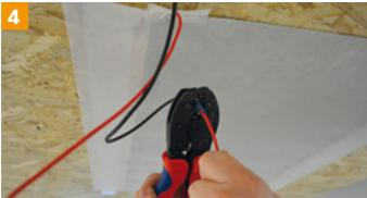
Anschlusskabel mit Zuleitung verbinden.
