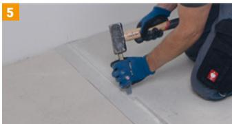
**5** Aussparung für Fühler-Anschluss-Set vorsehen. Fühlerhülse mittig unter der Heizfolie und mind. 60 cm von der Wand in den Raum anordnen.
