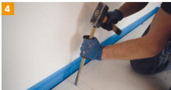
Aussparungen für die Zuleitungen und Kontaktierungen der Heizfolien einbringen.
