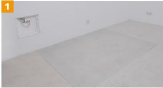
**1** Ebenen, sauberen, tragfähigen Untergrund vorbereiten. Trockenestriche und Holzwerkstoffplatten sind stets zweilagig und im Versatz auszuführen.
