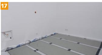
**Quicktherm Heizfolien PET** untereinander ausrichten und seitlich mit Isolierklebeband fixieren.
