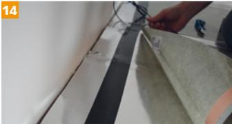
Isolierklebeband an Kopf- und Fußende in ganzer Breite unter der Schnittkante der Heizfolie anbringen.
