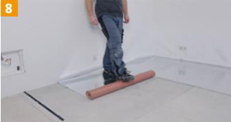
Trittschalldämmung gemäß Herstellerangaben auslegen.
