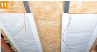
Den elektrisch aktiven Heizbereich (410 mm) stets mit einem Abstand von je 10 mm zu jeder Seite zwischen den Trockenbauprofilen ausrichten.
