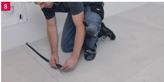
Fühler-Anschluss-Set in der Aussparung verlegen. Den externen Temperaturfühler bis zur Endkappe (Messpunkt) führen.
