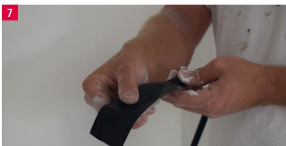
Die metallische Endkappe des Fühler-Anschluss-Sets mit Isolierklebeband abkleben um Fehlerströme zu vermeiden.
