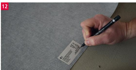
Widerstände zugeschnittener Folien erneut messen und auf dem Etikett, im Prüfprotokoll und in der Montage-Skizze dokumentieren – Sollwerte den Widerstandstabellen entnehmen.
