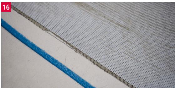
Heizfolie nicht über Dehnungsfugen verlegen und in einem Abstand von mind. 20 mm vor aufsteigenden Bauteilen (z.B. Wänden) enden lassen.
