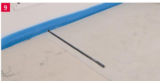
Für ideale Messwerte Metall-Endkappe bündig mit der Oberseite abschließen lassen.
