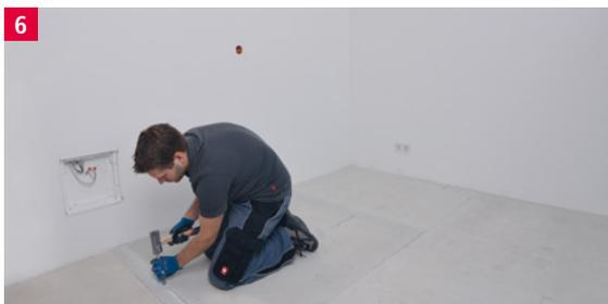
Aussparung für Fühler-Anschluss-Set vorsehen. Fühlerhülse mittig unter der Heizfolie und mind. 60 cm von der Wand in den Raum anordnen.
