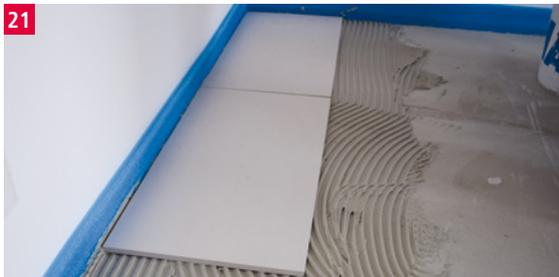
**Hinweis:** Fliesen können mit geeignetem Fliesenkleber gemäß Herstellerangaben direkt auf dem glattgezogenen Klebermörtel verlegt werden. Bei der Installation im Duschbereich/Nassbereich ist die Abdichtung oberhalb der Heizfolie anzuordnen. Das Durchdringen der Abdichtung (z.B. Bohrlöcher) ist nicht zulässig.
