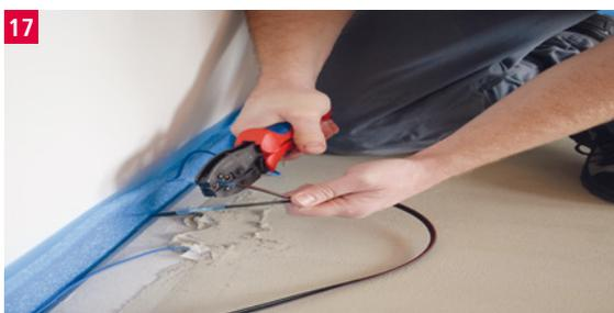
Anschlusskabel verlängern und zum Netzteil führen.
