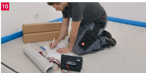
Widerstand gemäß den Widerstandstabellen überprüfen und Werte im Prüfprotokoll sowie in der Montage-Skizze dokumentieren.
