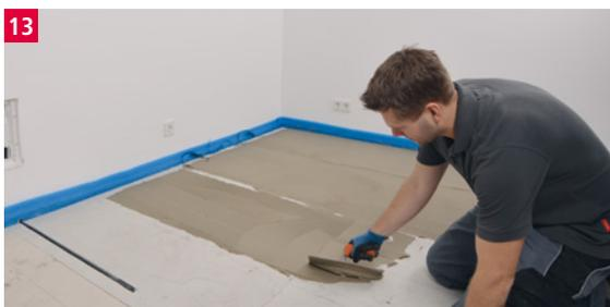
Klebemörtel zum Verkleben der Heizfolien gemäß Herstellerangaben auftragen.
