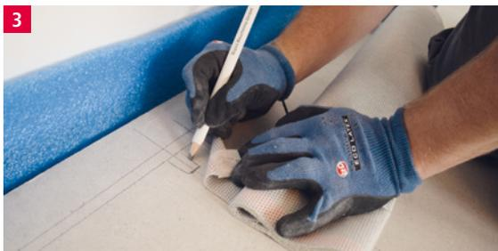
Kabelführungen sowie Aussparungen für die Heizfolienkontakte anzeichnen.
