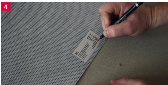
Bei zugeschnittenen Folien gemessene Widerstände auf beiliegenden Etiketten eintragen und auf der Heizfolie aufkleben.
