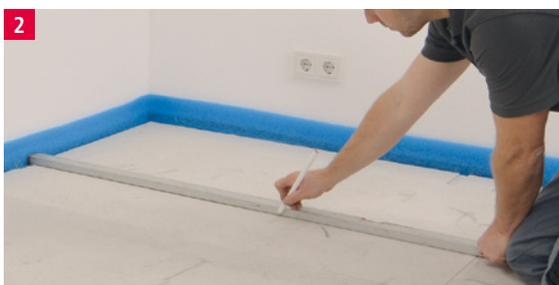
Position der Heizfolien anzeichnen und den Standort des Netzteils bestimmen. Montage-Skizze erstellen.
