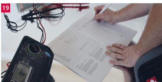
Widerstand nach dem Anschluss der Kabel erneut überprüfen und Werte im Prüfprotokoll sowie in der Montage-Skizze dokumentieren.
